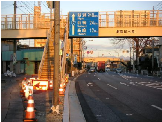
① 現況写真 (E0500101.JPG)
